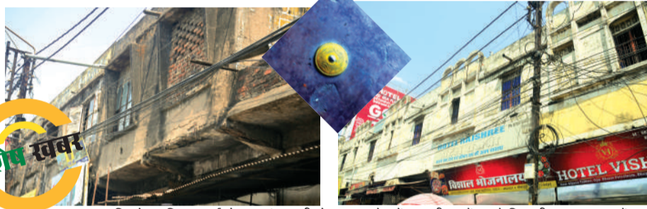
अल्पना तिराहे पर स्थित सूर्या होटल एवं राजश्री होटल। इनसेट में छत की दरारें मापने टिल्टमीटर लगाए गए हैं।
